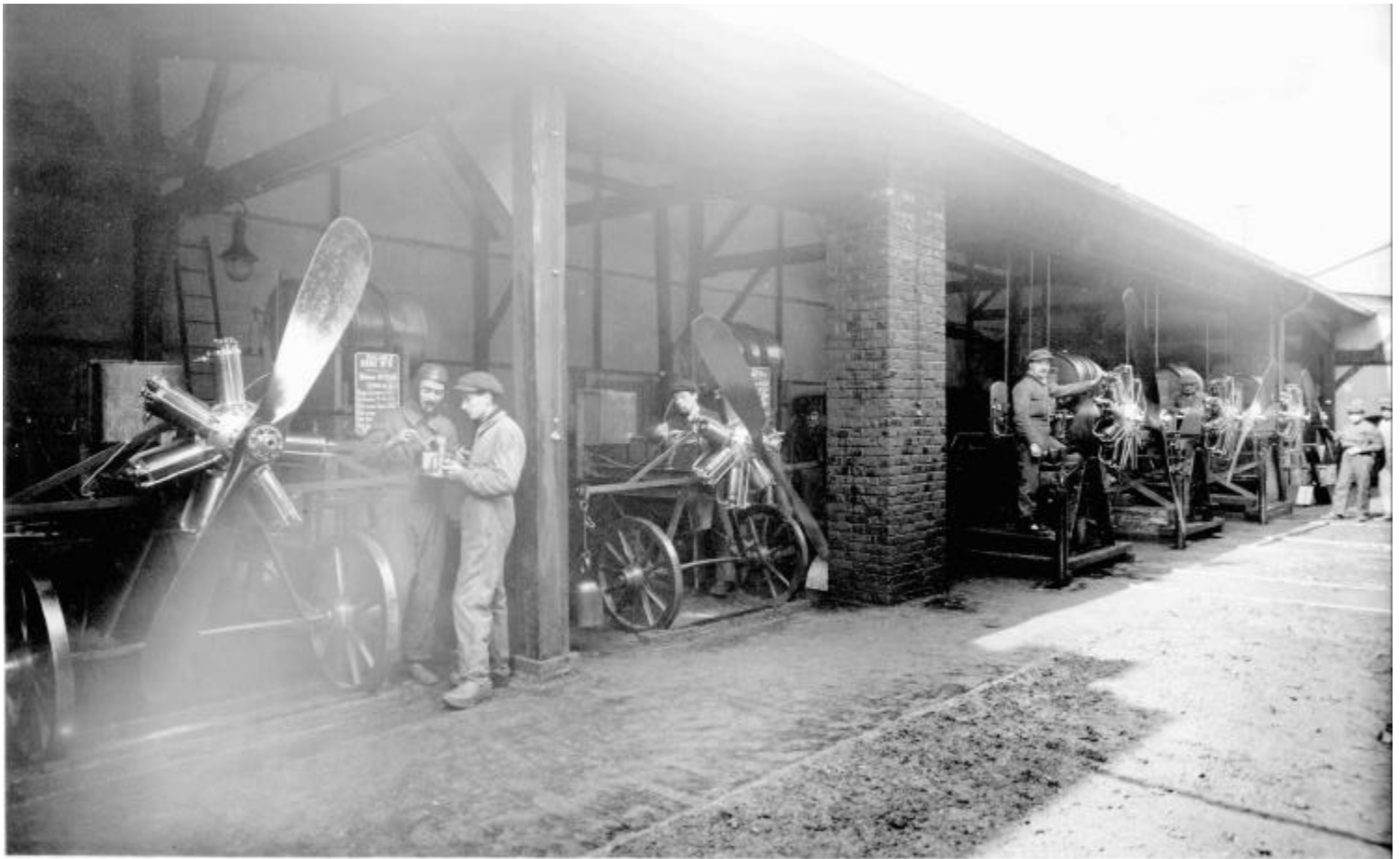
Bancs d'essais de la Société Clerget-Blin installés en 1918 sur l'île de la Jatte, en face de l'usine de Levallois. (Archives municipales de Levallois-Perret).
